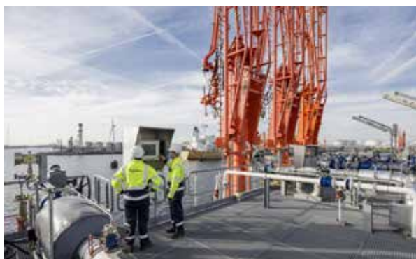
Agidens - Automatisation des bras de chargement chez Oiltanking Stolthaven
